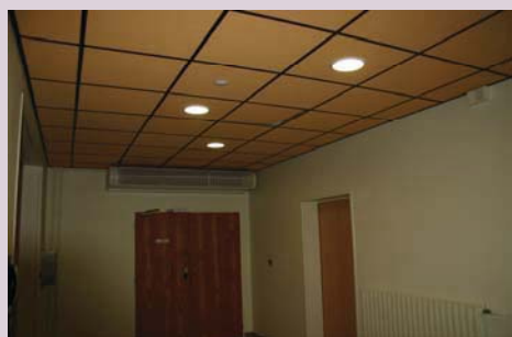
Hall de la salle des fêtes (éclairage, peinture et faux plafond)
