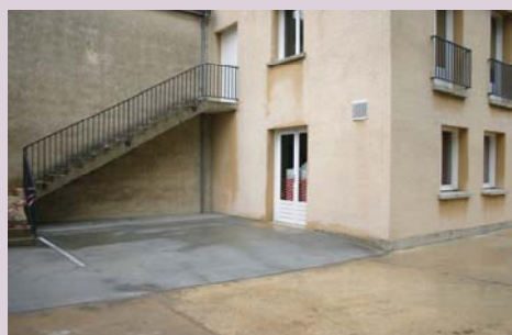
Dalle béton dans le passage traiteur de la salle des fêtes
