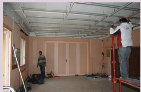
Isolation phonique de la salle de l'ancien billard et de la salle du club Loisir et Amitiés
