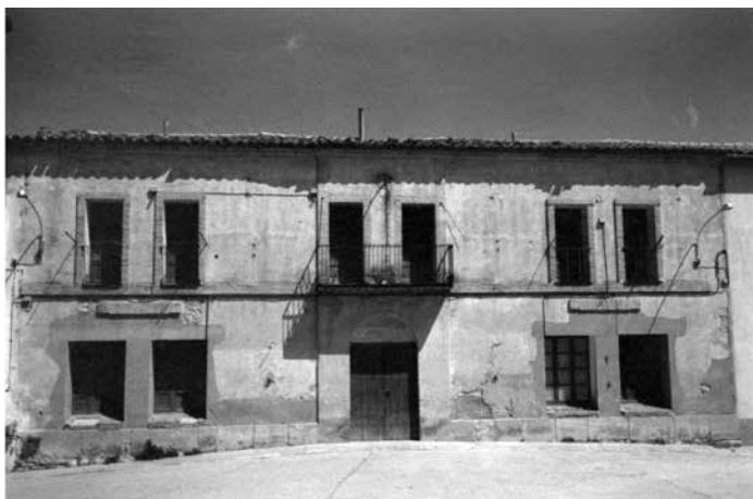
Edificio escolar en Montolíu de Lérida. Sección de niños: a la derecha en la planta baja, y en la parte alta del mismo lado vivía Pepe con su familia. Abajo, del lado izquierdo estudiaban las niñas, y arriba habitaba la maestra. Fotografiado en 1990 por Fernando Jiménez
